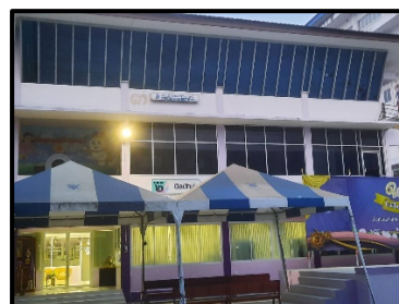
อาคาร 2 นิลปัทม์
